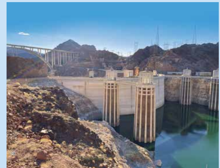
Hooverova přehrada je označována za nejslavnější stavbu svého druhu na světě. Stavět se začala v roce 1931 a zprovozněna byla o pět let později. Hráz má ve své patě tloušťku 201 metrů. Světlý pás vypovídá o úbytku vody, která před 30 lety sahala až k vrcholům věží
